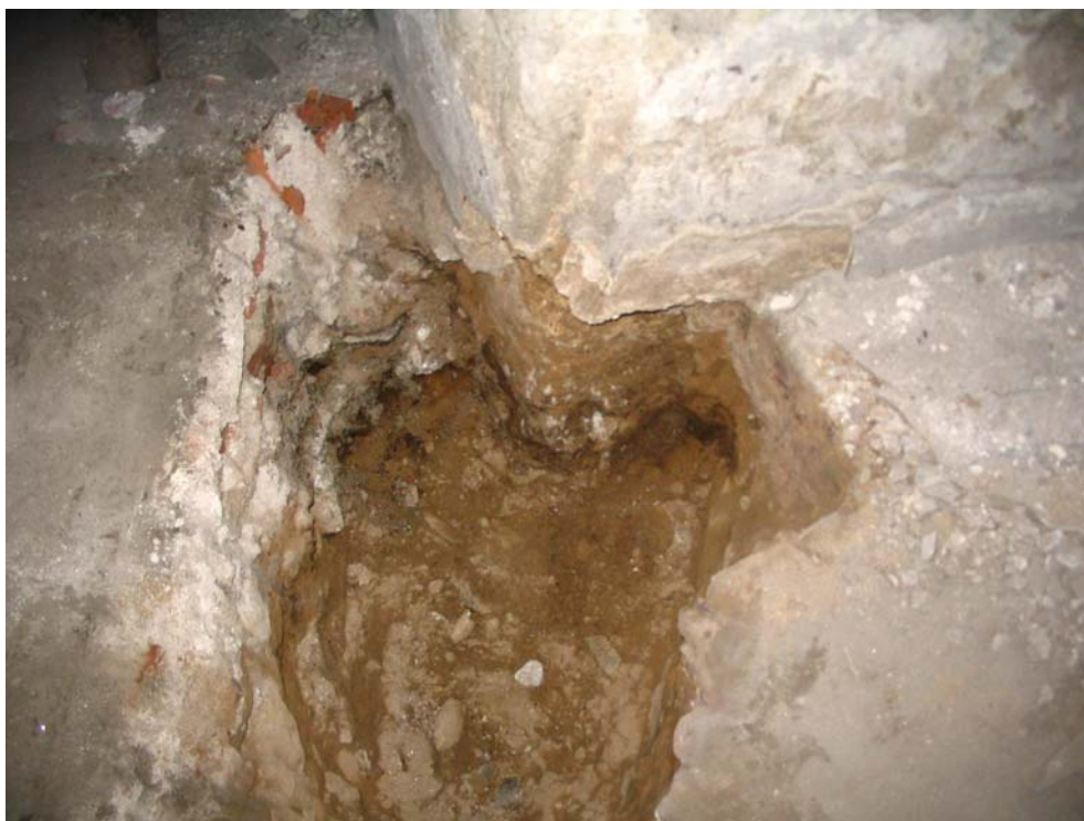
Foto 2: Sonda KS 2, přízemí, pohled do sondy (sonda provedena u patky pilíře klenby v přízemí)
