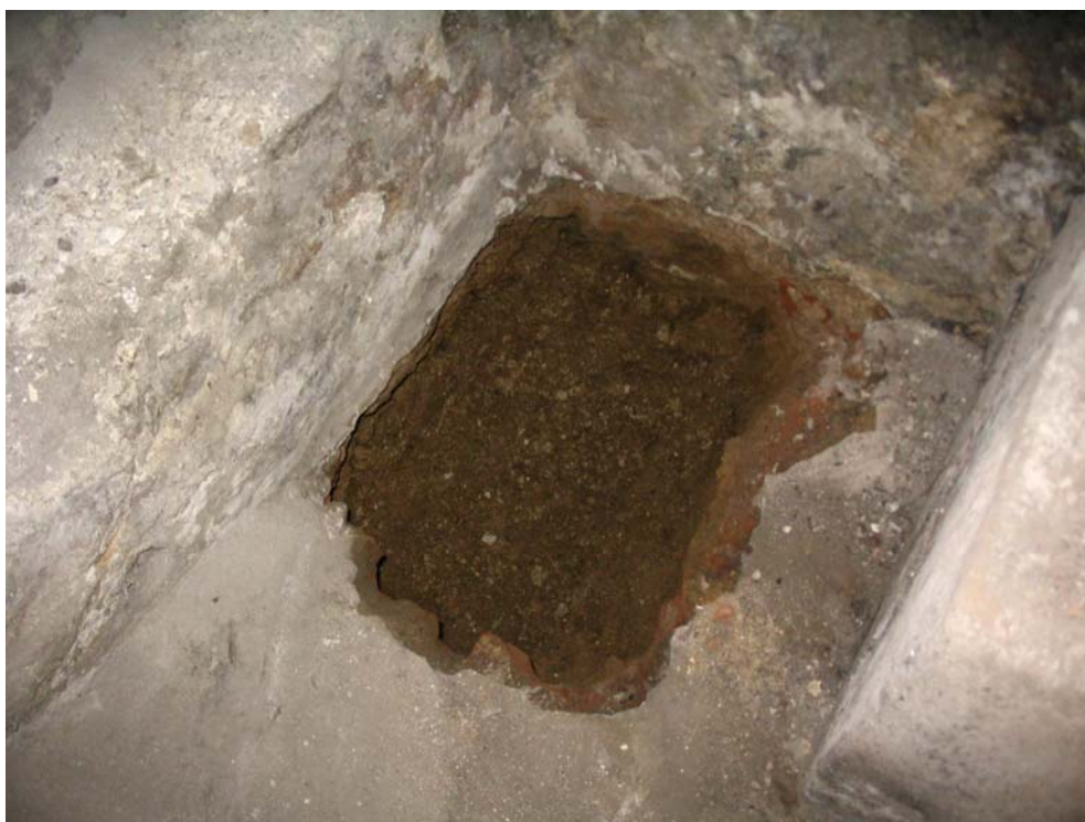
Foto 4: Sonda KS 4, přízemí, pohled do sondy (sonda provedena u styku stěn u schodiště v přízemí)
