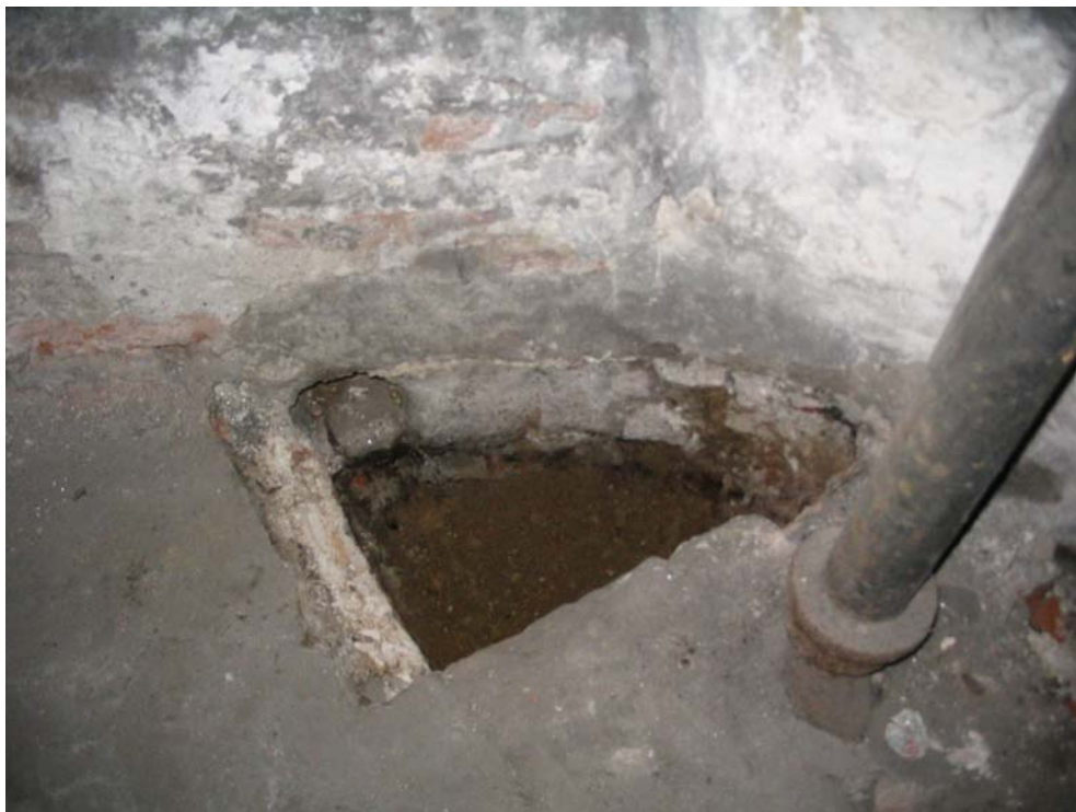
Foto 3: Sonda KS 3, přízemí, pohled do sondy (sonda provedena u napojení šikmé stěny na patku pilíře klenby v přízemí)
